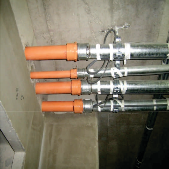
Kết nối với vật liệu khác (Ống thép)
